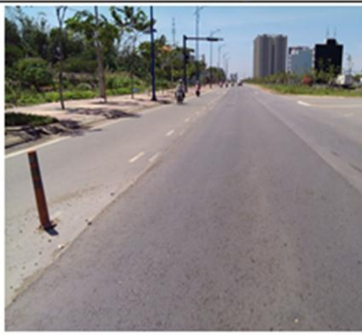
Sau khi thi công
