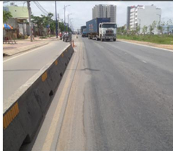
Trước khi thi công
